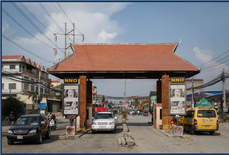
ด่านเก็บค่าผ่านทางในกัมพูชาในกรุงพนมเปญ
