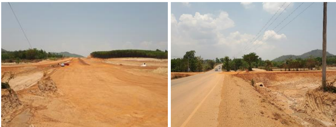
รูปที่ 8.13 บริเวณพื้นที่ก่อสร้างด่านพรมแดนแห่งใหม่
