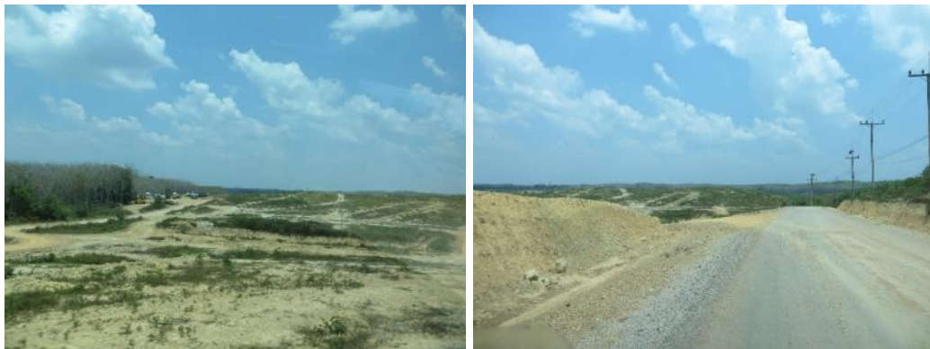
รูปที่ 8.6 พื้นที่ก่อสร้างด่านพรมแดนแห่งใหม่
