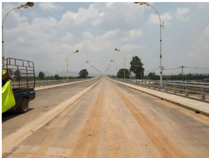
รูปที่ 8.14 สะพานข้ามแดนแห่งที่สองที่อยู่ระหว่างการดำเนินการก่อสร้าง
