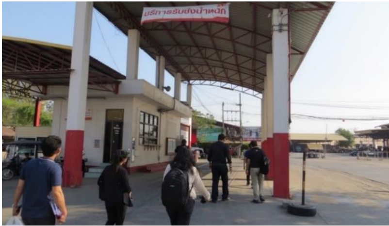
รูปที่ 6.9 จุดซิ่งน้ำหนักรบรรทุกภายในสถานี
