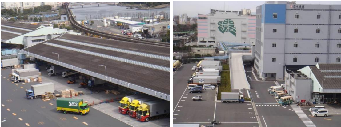
รูปที่ 2.14 อาคารขานชลภายในสถานีขนส่งสินค้า Keihin
