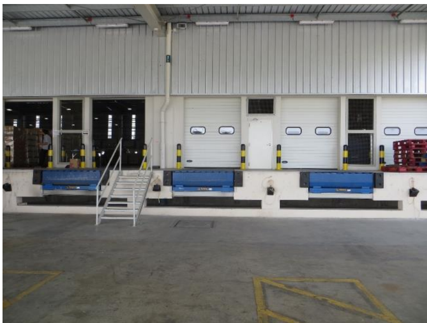
รูปที่ 6.17 ทำจุดเทียบขนานขาลาสำหรับรถบรรทุก
