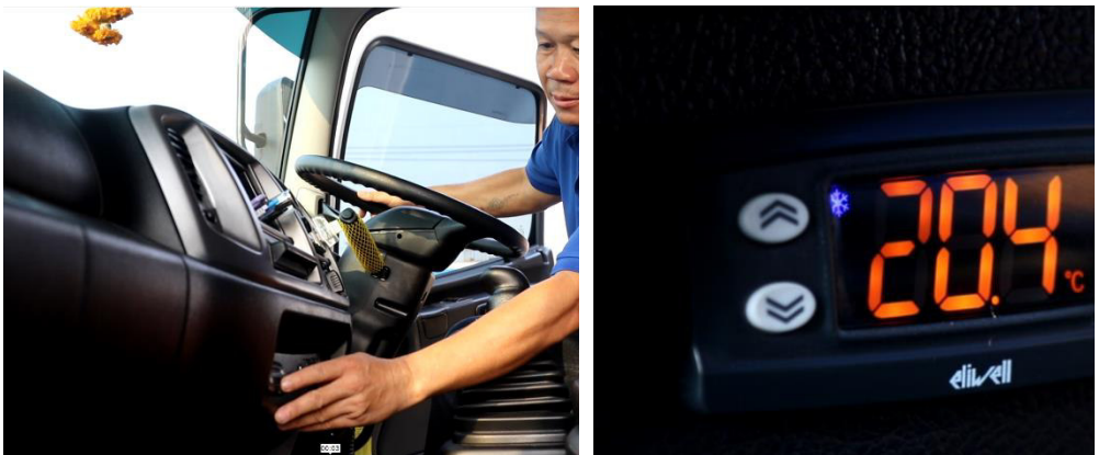
รูปที่ 4.22 การติดตั้งหน้าจอแสดงผลอุณหภูมิแบบดิจิทัลภายในห้องคนขับ
