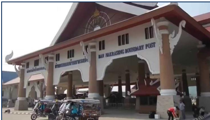
ด่านบ้านนากระเซ็ง อ.ท่าลี่ จ.เลย เชื่อมกับด่านแก่นท้าว (ลาว) ผ่านสะพานข้ามแม่น้ำเหือง
