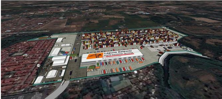
Dry Port และ Logistics Park ของ ICTSI ชื่อ Laguna Gateway Inland Container Depot (LGICD) เป็นท่าเรือบกของ ICTSI ให้บริการคัดแยก รวบรวม และบรรจุสินค้าคอนเทนเนอร์ เพื่อการนำเข้าและส่งออก
